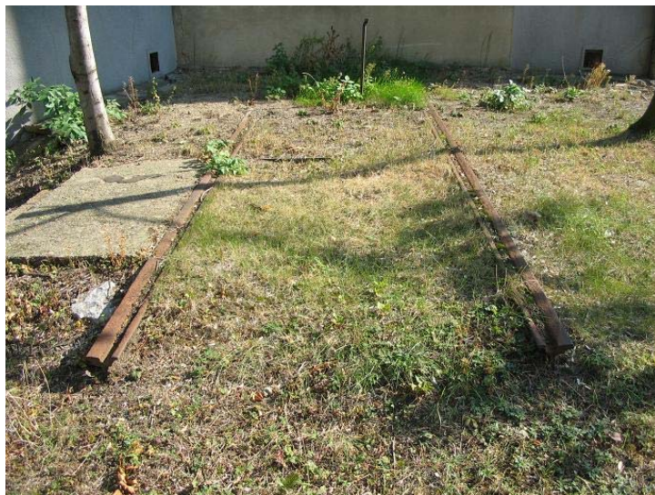
Kolejnice, po níž byly do měnárny dopravovány transformátory a jiná těžká zařízení
